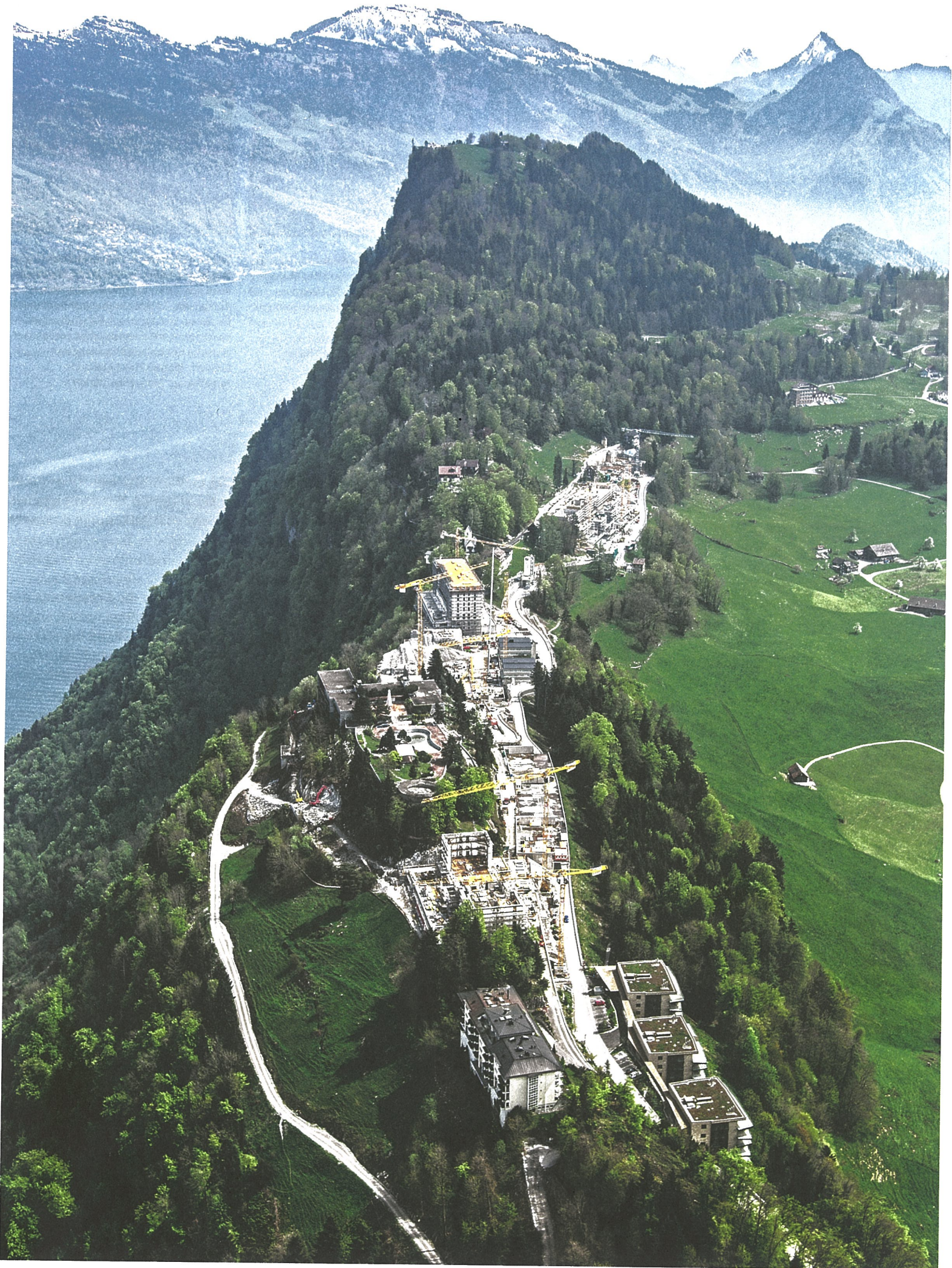
Baustelle hoch über dem Vierwaldstättersee: 2017 sollen auf dem Bürgenstock 800 Hotelbetten, 68 Ferienwohnungen und ein Gesundheitszentrum in Betrieb gehen.
